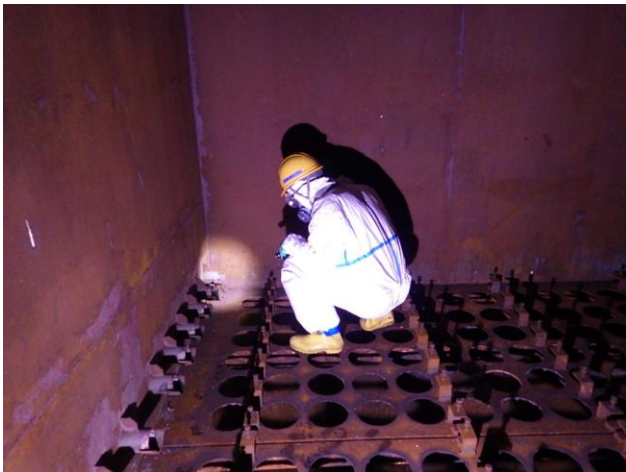
集じん機（バグフィルター）除染後
