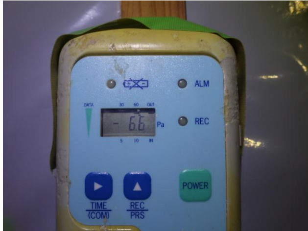
負圧計による密閉養生確認
