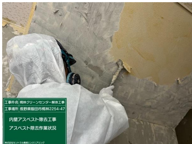
除去作業（湿潤化後）
