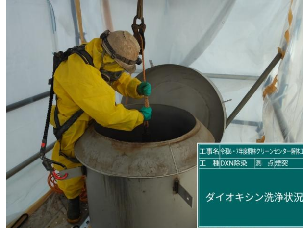
除染（洗浄作業）
