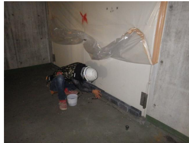
防液堤の設置確認
