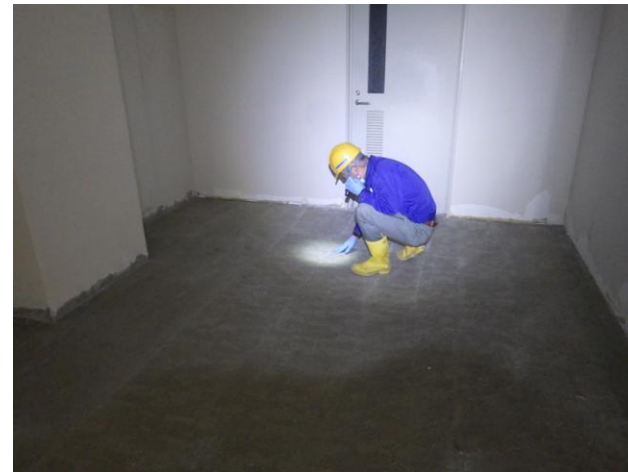
アスベスト含有建材撤去後
