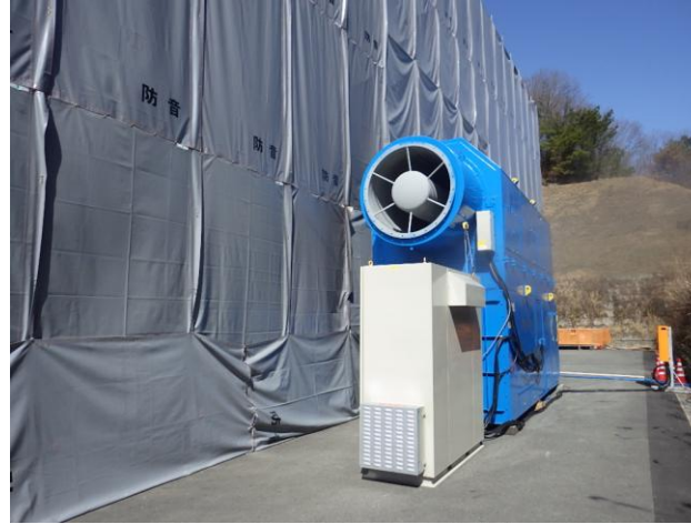
負圧集じん機設置状況
